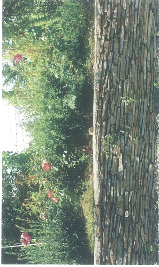
Helyi lapos kőből készített támfal Egregyén
