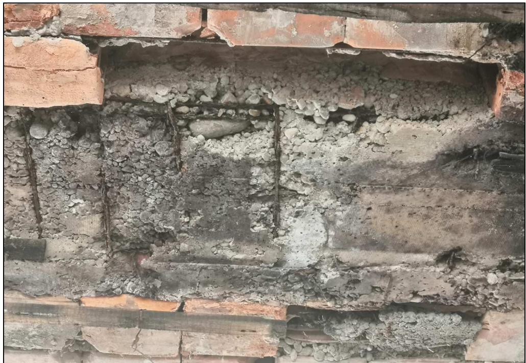
25. és 26. Ábra: elrozdásodott betonacélok vápa vasbeton lemezében
