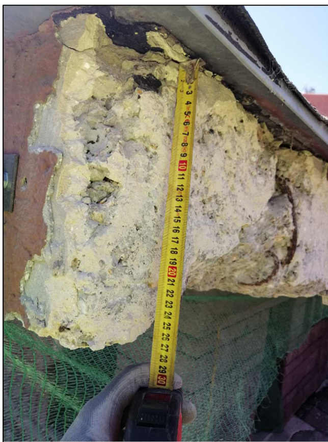
27., 28. és 29. Ábra: Feltárt födém szerkezet észak-keleti saroknál
