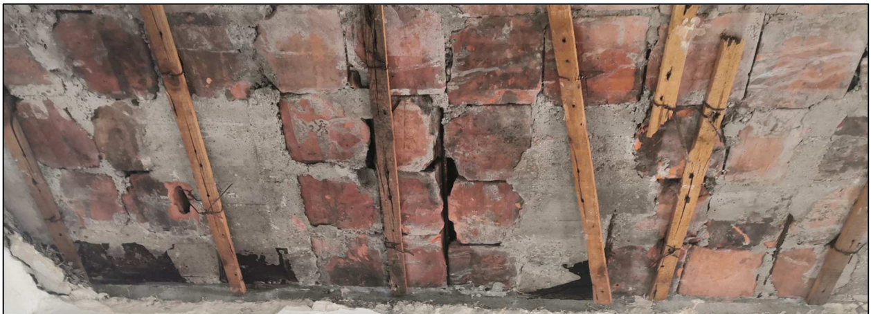
31. Ábra: Bohn-födém vasbeton gerendákkal, északi oldalon, 1-2 raszterek között
