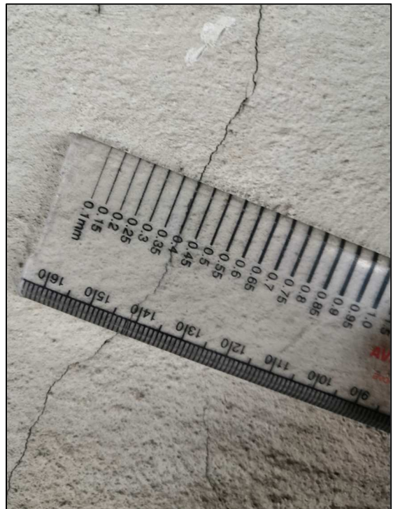
13. Ábra: 7-es raszterben lévő gerenda repedéstágassága
