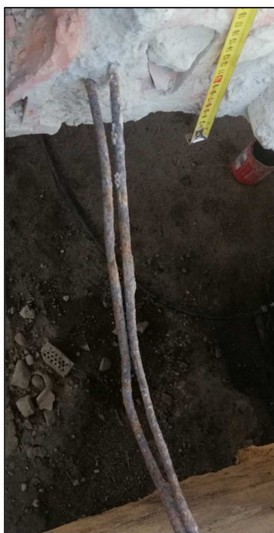
18-22. Ábra: Rossz minőségben készült Bohn födémrendszer 23. és 24. Ábra: Korrodált betonacélok toldás helyén
