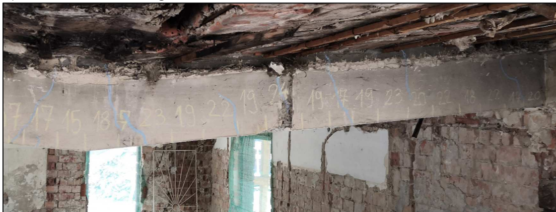
9. Ábra: Repedéskép a 7-es raszterben lévő keretgerendán
