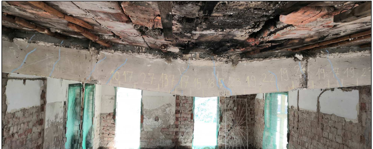
8. Ábra: Kengyelkiosztás és repedéskép, 7-es raszter
