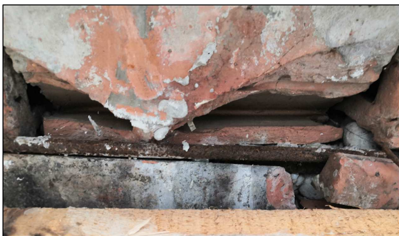
18-22. Ábra: Rossz minőségben készült Bohn födémrendszer 23. és 24. Ábra: Korrodált betonacélok toldás helyén
