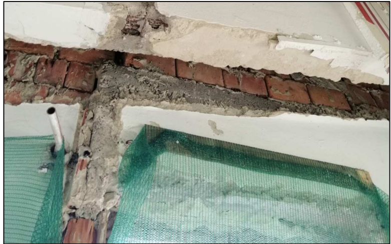
14. és 15. Ábra: Északi oromfal ajtónyílásokfeletti monolit vasbeton áthidalók
