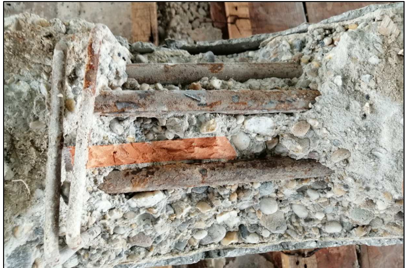
12. Ábra: Feltárt keretgerenda 7-es raszterben: tégladarabok a beton szerkezetben
