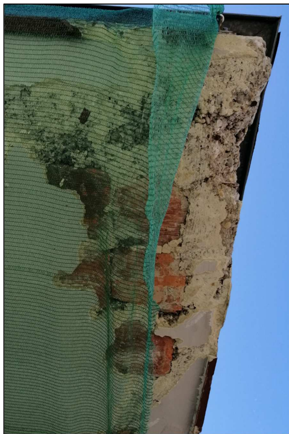
27., 28. és 29. Ábra: Feltárt födém szerkezet észak-keleti saroknál
