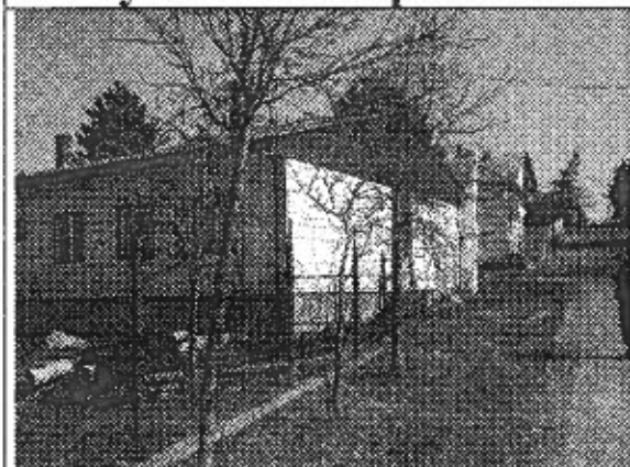
Árpád utca 28 D-Ny homlokzat
