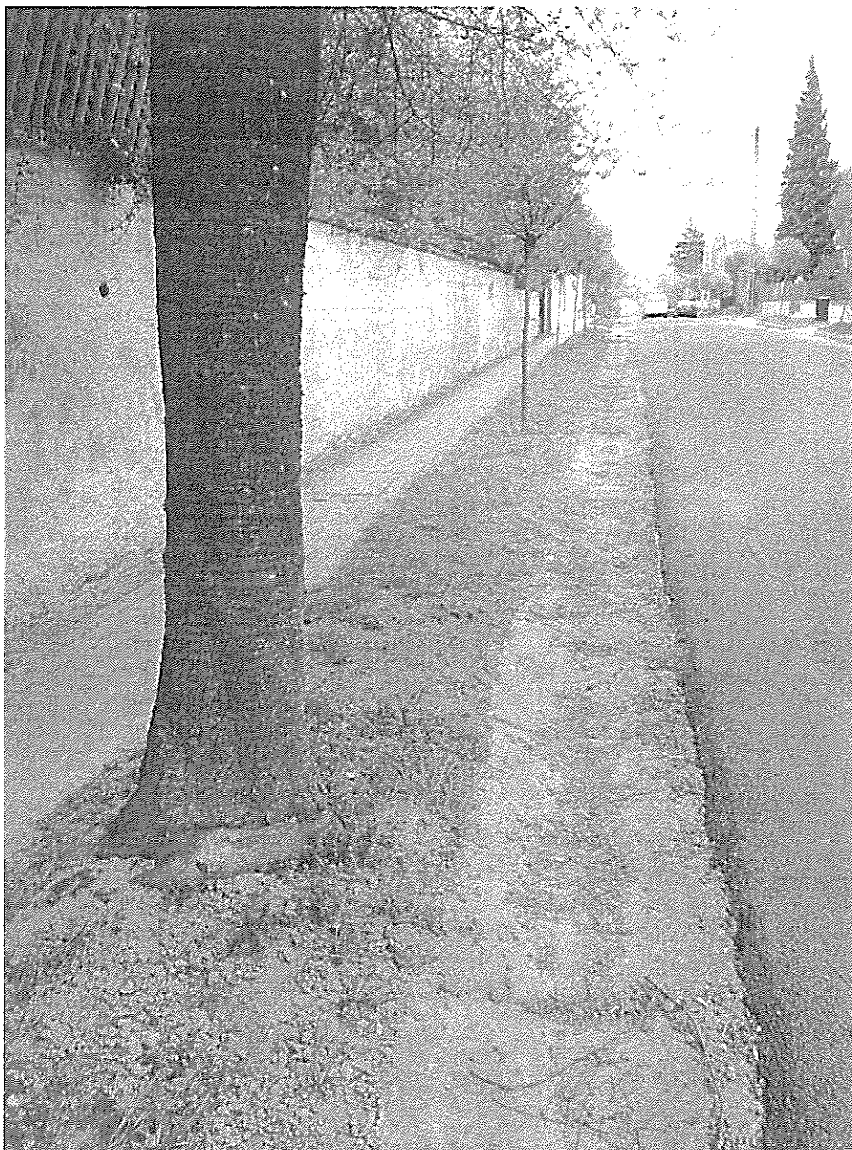
A csapadékvíz elvezetés az aszfaltozott út mentén, nyílt árokban történik. A víz elfolyását biztosítani szükséges.
