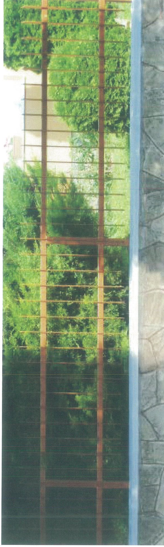
Áttört filigrán fém szelvényekből kialakított kerítésmező
