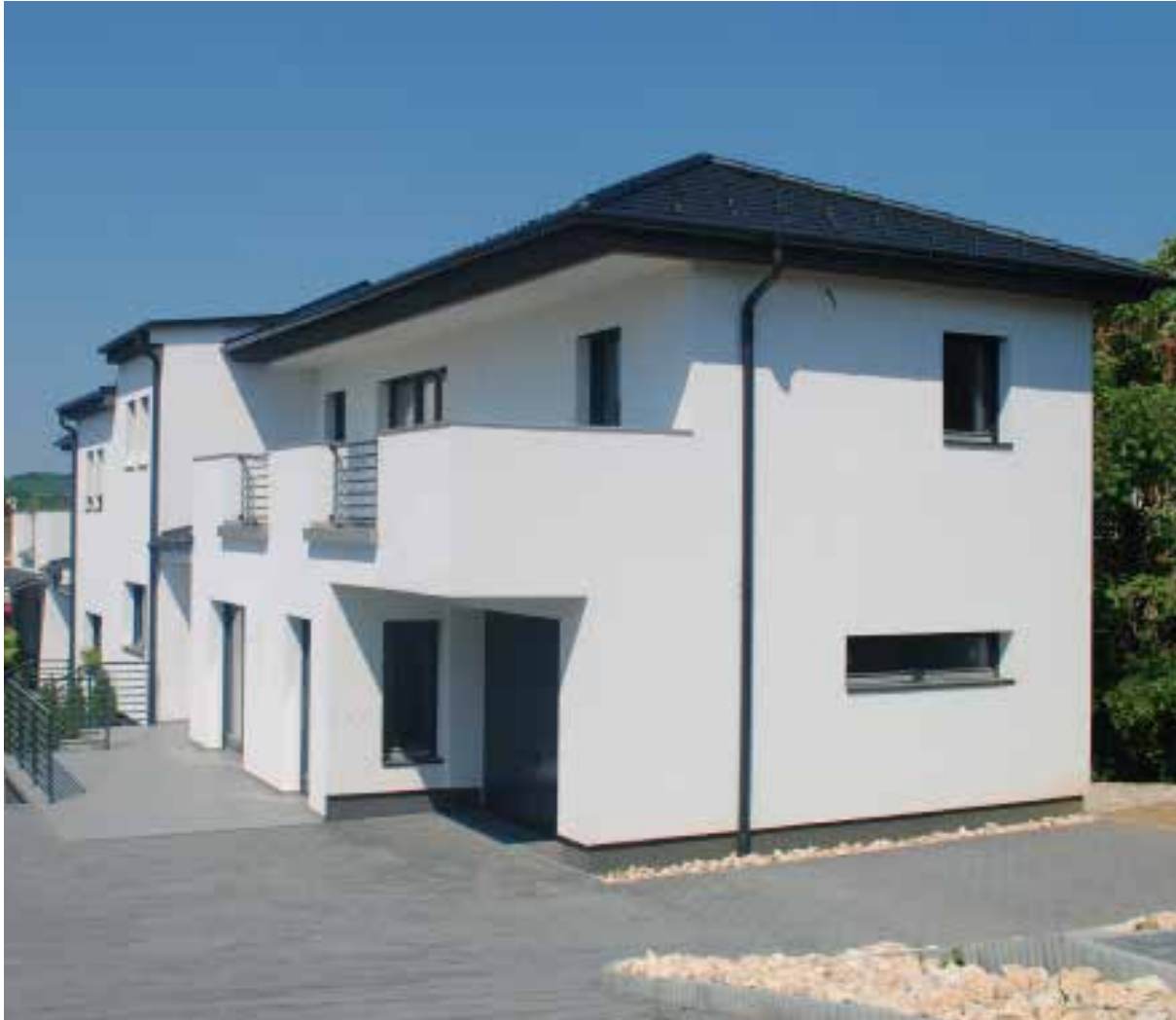
Tömegformálásban, anyag- és színhasználatában visszafogott lakóépület. A fehér vakolt falak és antracit színű cserépfedés illeszkedő hatást kölcsönöz.
