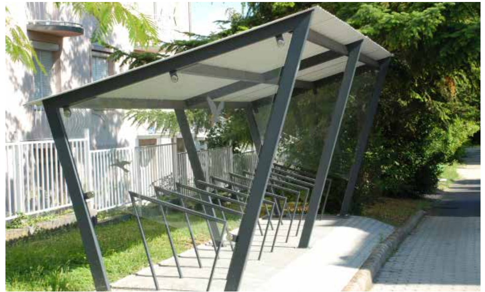
Légies szerkezetű kerékpártároló, fémszerkezetből kialakítva.
