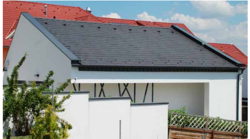
Jó példa anyag és színhasználat tekintetében, fehér vakolt fal, antracit színű téglány cserépfedés színben illeszkedő kiegészítő bádogos szerkezetekkel
