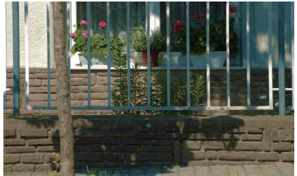
Kerítés kialakítása tömör lábazattal és áttört kerítésmezővel
