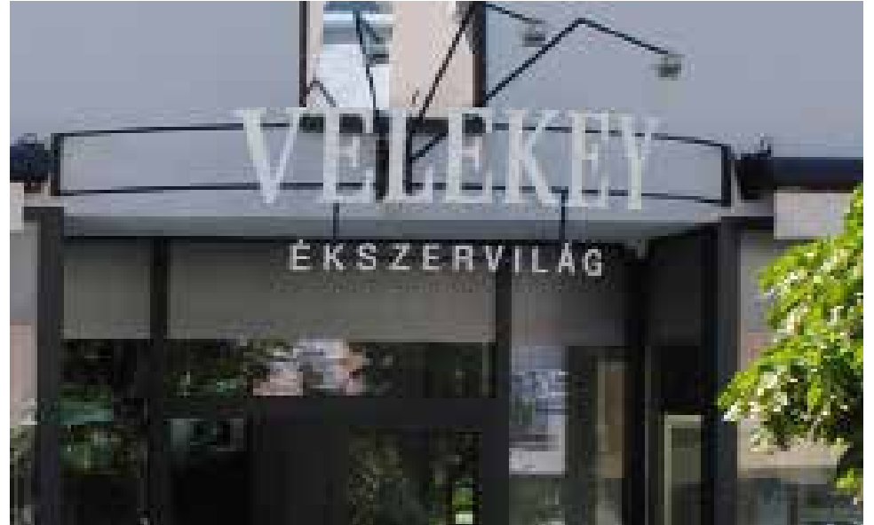
Boltrészlet igényesen kialakított portálszerkezet és boltfelirat, Rákóczi utca
