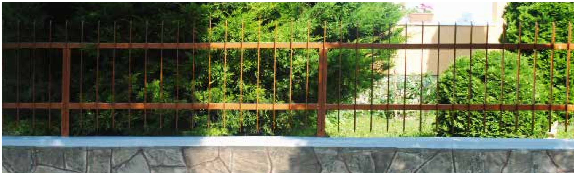
Áttört filigrán fém szelvényekből kialakított kerítésmező
