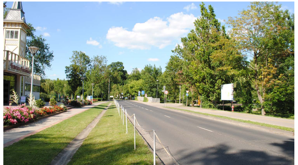
Példa igényesen kialakított, rendezett zöldfelületekkel szegélyezett útszakaszra. Nagyobb utak mentén, városképi és tájképi szempontból jelentős területeken kerüljük reklámhordozók kihelyezését.
