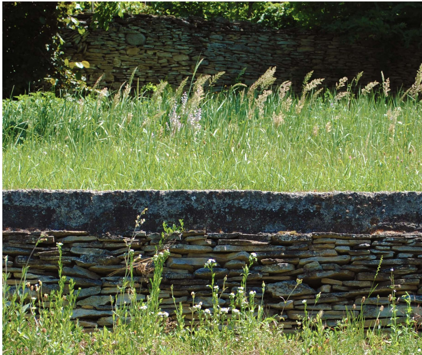
Helyi lapos kőből készített támfal
