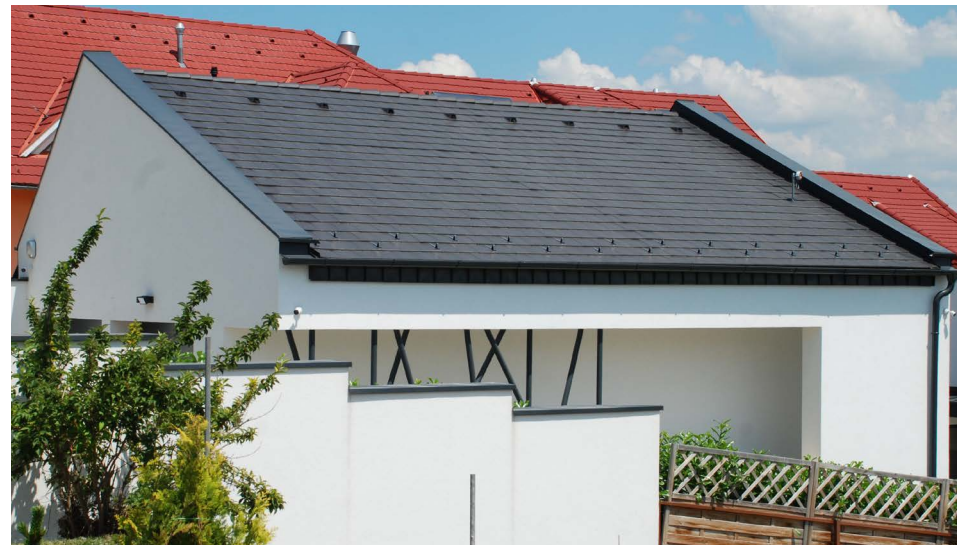
Jó példa anyag és színhasználat tekintetében, fehér vakolt fal, antracit színű téglány cserépfedés színben illeszkedő kiegészítő bádogszerkezetekkel
