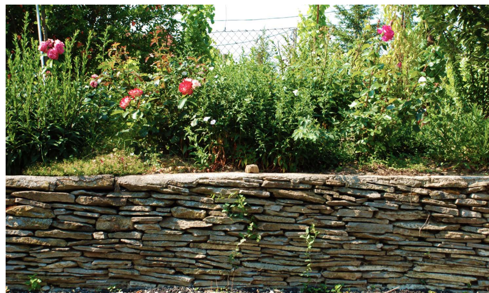
Helyi lapos kőből készített támfal Egregyen
