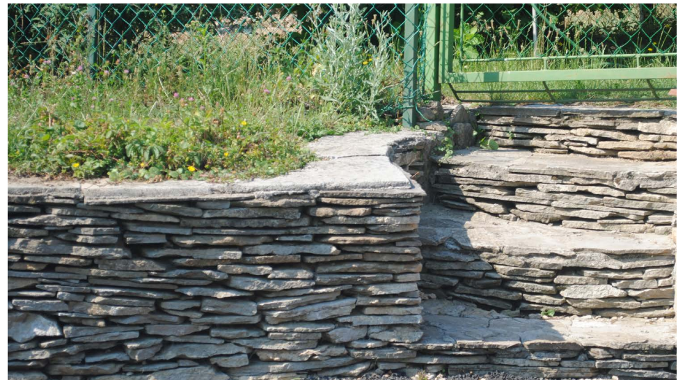
Helyi lapos kőből készített támfal és tereplépcső környezetbe illeszkedő megjelenést eredményez
