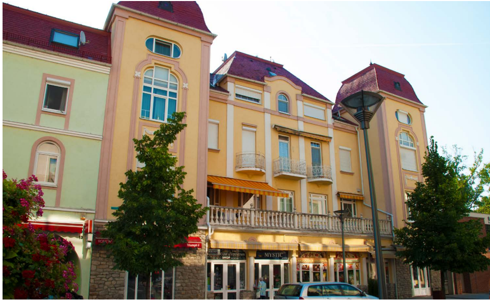
Gabi villa helyi védett épülete / Rákóczi utca 15.
